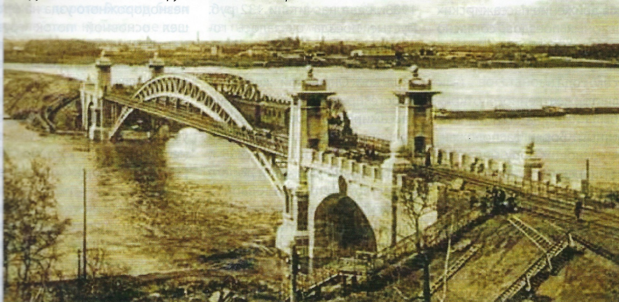
Сооружения Московской окружной железной дороги
