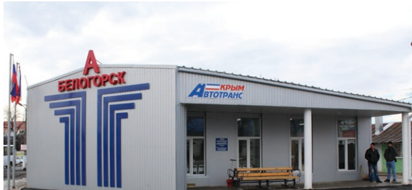
Новое здание автостанции «Белогорск»
