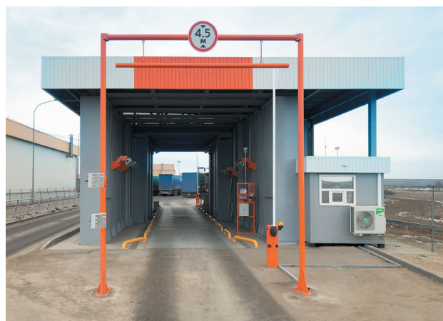
Рисунок 3. Портальный ИДК в двухракурсном исполнении «Портал-9232» в МАПП «Маштаково»
