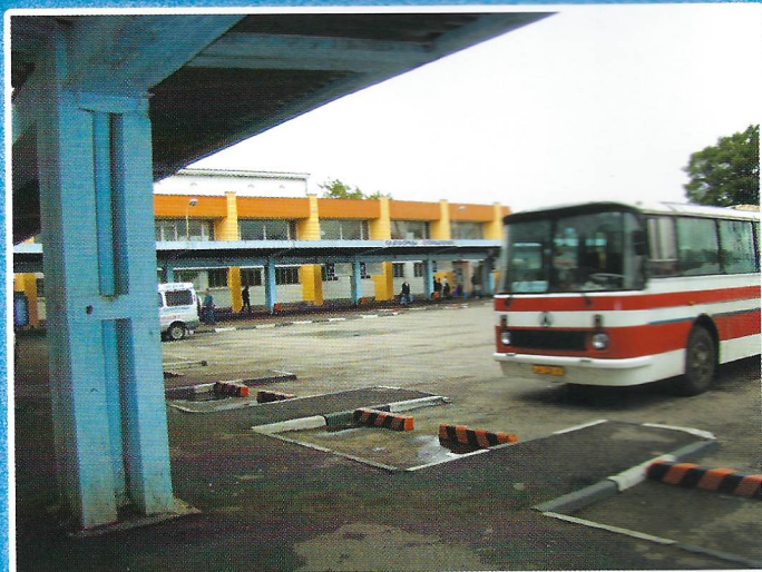
Обновленные перроны прибытия отправления автобусов гармонично вписываются в ансамбль автовокзала
